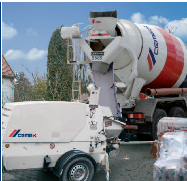
Der Fließestrich gelangt einbaufertig im Fahrmischer auf die Baustelle und ist dort sofort pump- und verarbeitbar
