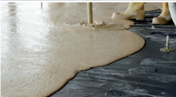
Einbau des Fließestrichs auf dem Hohlboden. Gute Fließfähigkeit und Homogenität zeichnen Calciumsulfat-Fließestrich besonders aus.
